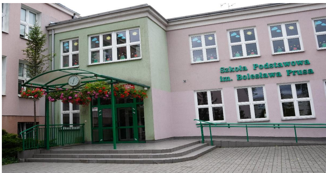
Wejście do budynku Szkoły od części dobudowanej
