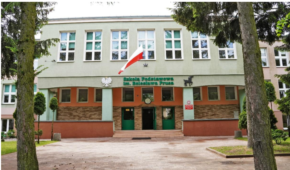
Wejście główne od ul. Pocztovej
